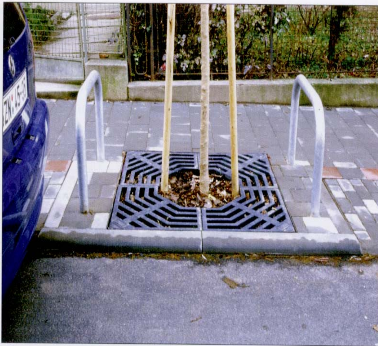
foto. 9 Jednoduché zábrany z pozinkovaných trubek zabraňující poškození kmene ( Prunus serrulata 'Kanzan') najetím automobilů. Proti zhutnění povrchu je použita pochozí mříž.
