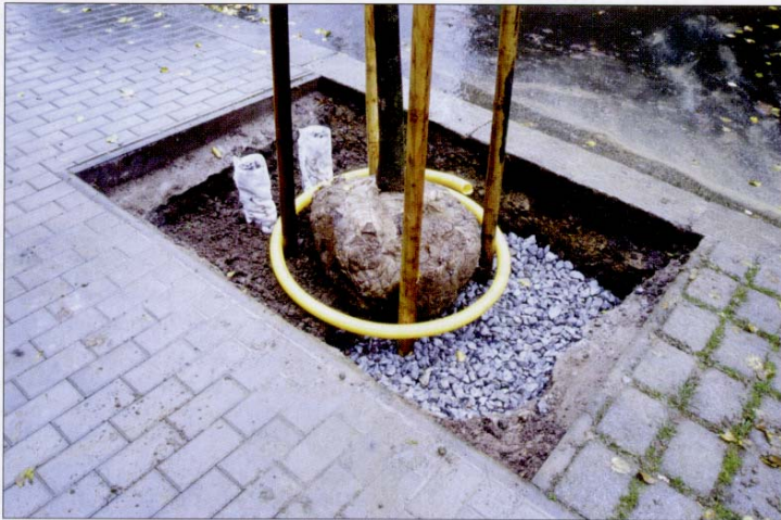
foto. 4 Spodní vrstva v hloubce 0,40 - 0,80 m je tvořena štěrkem frakce 8 - 32 mm (50 %), pískem 0,063 - 3 mm (30 %), místní podomíčí (20 %) a přídavkem 15 kg bentonitu. Vrchní vrstva je tvořena omíčí z 55 %, štěrkem (spilít) 8 - 16 mm (25 %) a pískem 0,063 - 3 mm (20 %). Na spodní vrstvu navazují větrací rukávce vyplněné štěrkem 16 - 32 mm.
