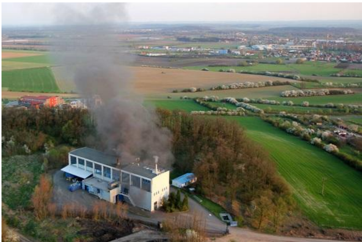
Obr. 1: Fotografie pořízená náhodou zachycuje havárii ve spalovně v Lysé nad Labem, o které se později ukázalo, že jde o problém spojený s nesouladem mezi technologií spalovny a filtrem na zachycování dioxinů (PCDD/F).
