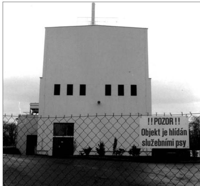
Spalovna nebezpečných odpadů v Lysé nad Labem.
