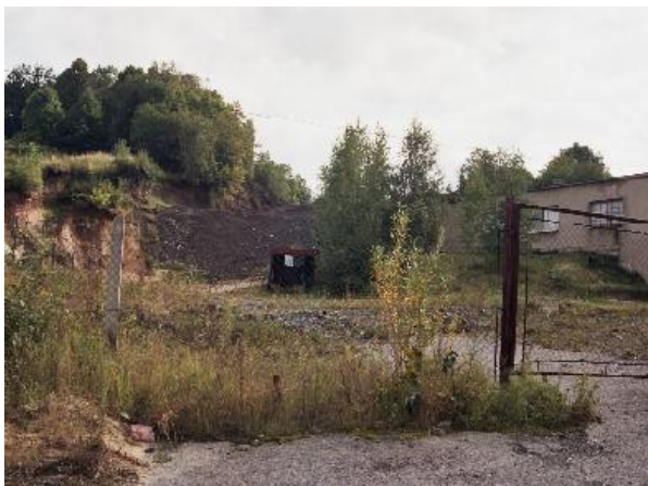
Foto č.6 : Skládka odpadu Čefos Větrov, kde byla směs SPRUK ze spalovny Termizo použita na výstavbu příjezdové cesty a na překrytí povrchu skládky.
