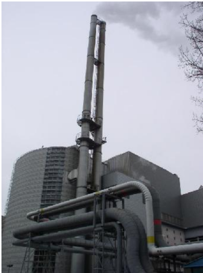
Foto č. 8: SKO Termizo Liberec, leden 2005.
