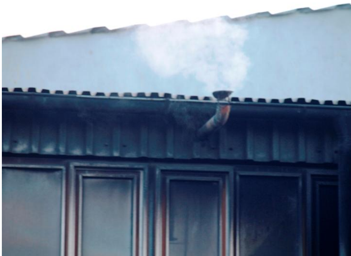
Obr. 1: Fotografie větracího komínu spalovny a emisí z něj. Záběr byl pořízen 7. února 2013. Je na něm patrné i znečištění okolí větracího komínu. Foto: J. Petrlík, Arnika
