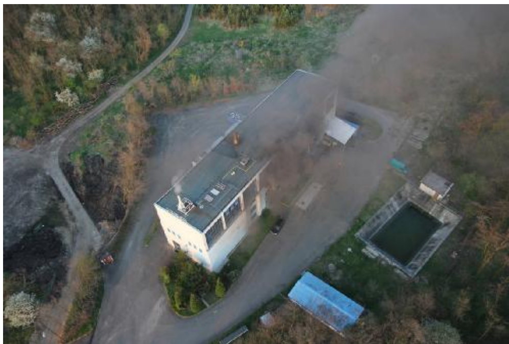
Obr. 4: Havárie spalovny nebezpečných odpadů v Lysé nad Labem, ke které došlo v dubnu 2013. Foto: Arnika, web.
