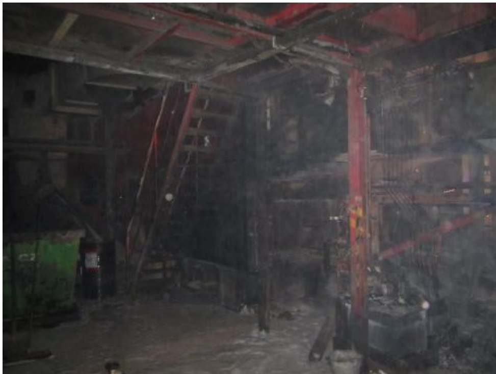
Obr. 3: Vnitřek spalovny ve Zlíně – Malenovicích po zásahu požárníků v roce 2016. Foto: HZS Zlínského kraje.
