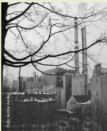
Spalovna odpadů v Liberci
