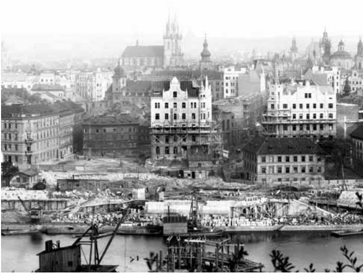
Josefov při asanaci, vpředu stavba nábřeží a Čechova mostu, 1906
