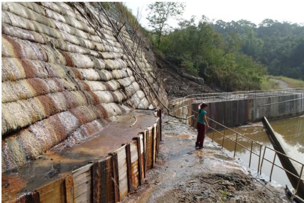
Obrázek 35: Jedna z lokalit, kde se skládkuje popílek ze spaloven odpadu, v jižní části Tchajwanu. Foto: Jindřich Petrlík, leden 2017.
