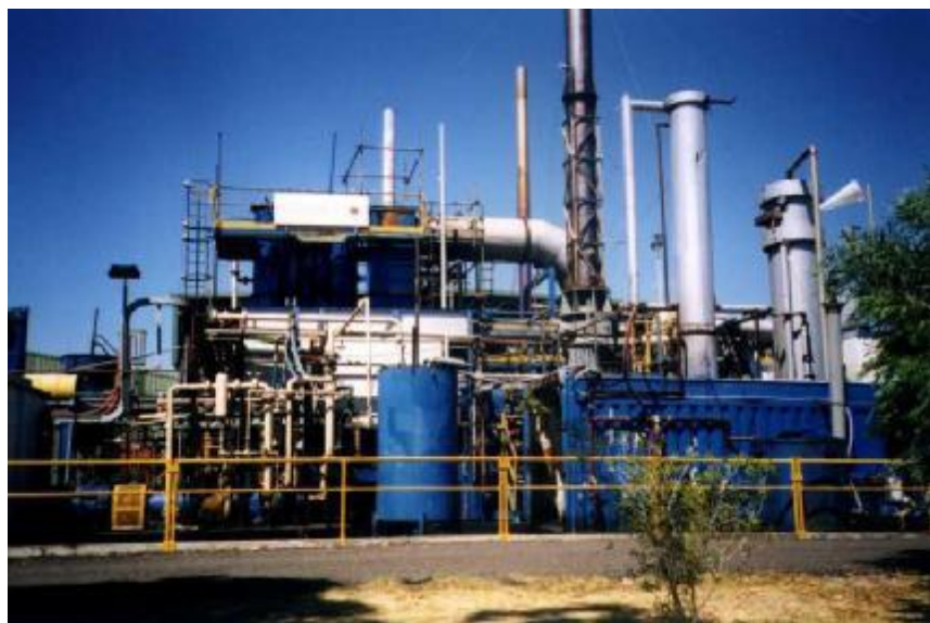
Obrázek 34: Provoz firmy Eli Ecologic využívající technologii chemické redukce v plynné fázi, Kwinana, Západní Austrálie. Zdroj: Halett (2013).
