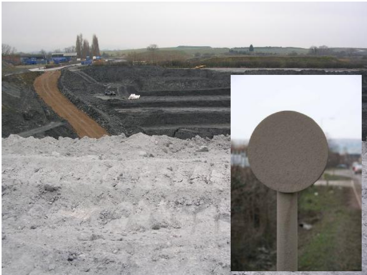
Obrázek 4: Na fotografii je vidět světle šedý povrch zbytků z čištění spalin na skládce v Bishops Cleeve, na jednom z míst ve Velké Británii, kam se ukládá popílek. Na vložené fotografii je značka omezující rychlost na 40 mil za hodinu na kraji přístupové cesty na lokalitu. Zdroj: Watson (2015).
