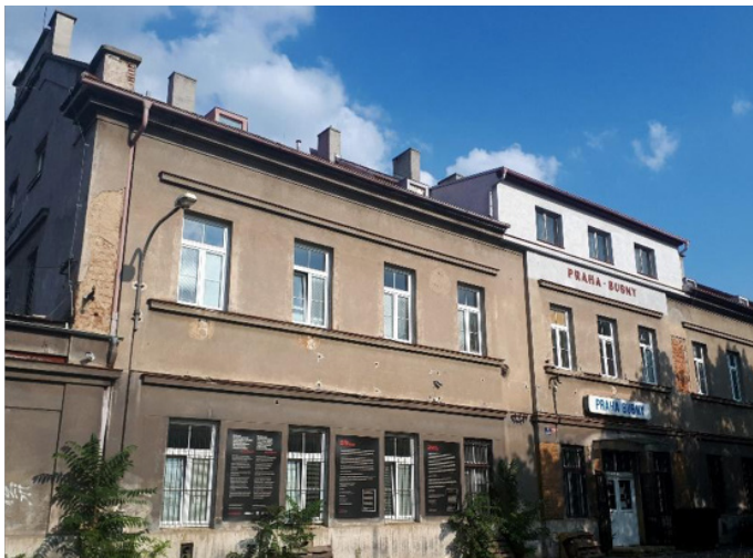
Obr. 7 Nádražní budova Praha – Bubny
