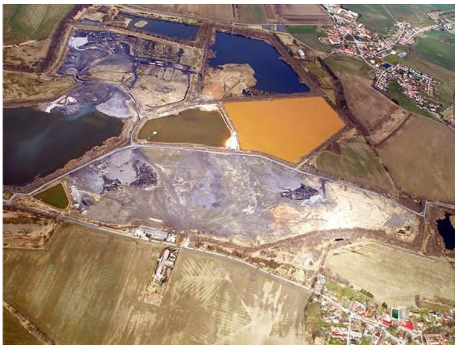
Obrázek 12: Letecká fotografie lagun po zpracování uranové rudy v závodu v Mydlovarech v jižních Čechách. Laguny jsou již částečně vyplněné směsí odpadů, která obsahuje popílek. Zdroj: mail.oakrupkovo.cz.
