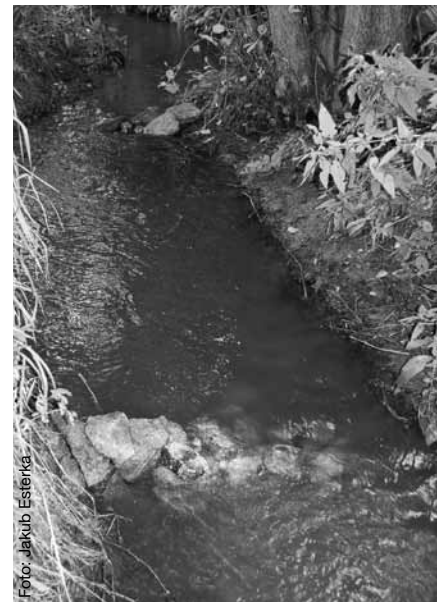
Kamenné půlprahy k nastartování přirozeného meandrování toku.
