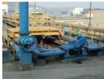
Lapač písku ÚČOV Praha. Foto: P. Hoffmann, fs.cout.cz
