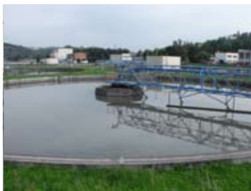
Jedna z usazovacích nádrží v ÚČOV Praha. Foto: Univerzita Wageningen
