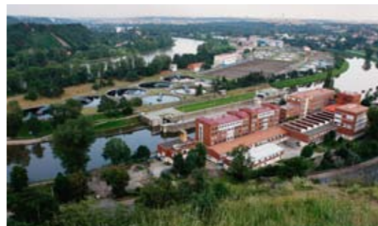
Ústřední čistírna odpadních vod v Praze na Císařském ostrově nesplňuje v současné době limity ohledně emisí dusíku. Výjimku na kvalitu vypouštěných vod dostala do roku 2016. Foto: J. Losenický, Arnika
